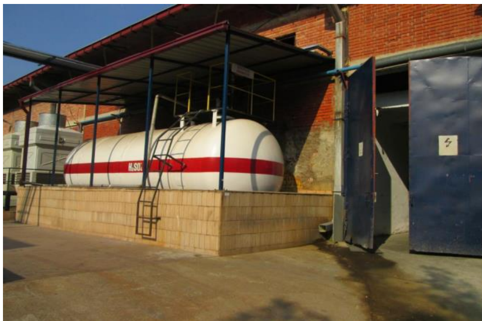
Слика 4 Резервоар за сулфурна киселина
